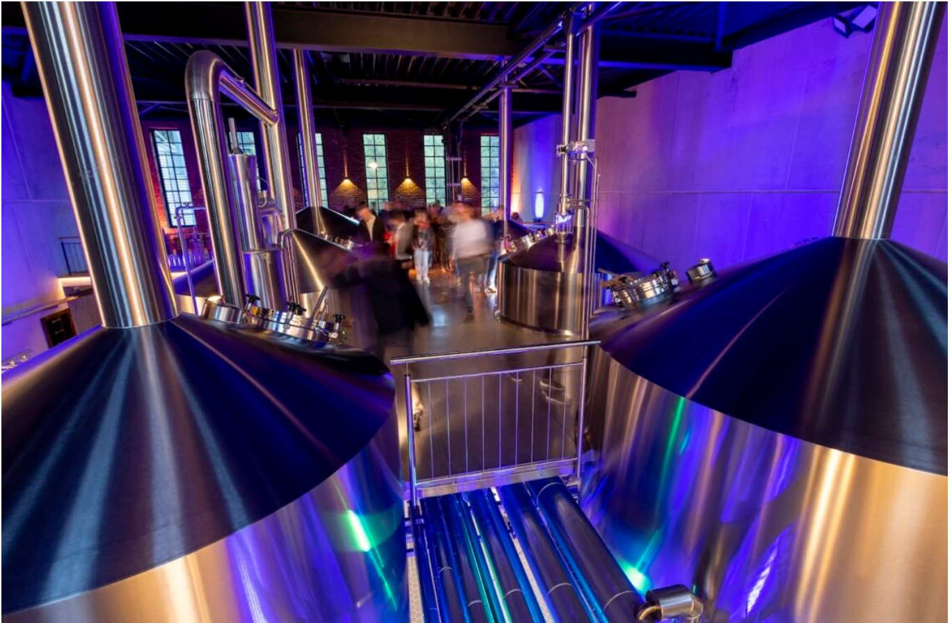
Das Sudhaus der Westerwald Brauerei (Foto: Westerwald Brauerei)
